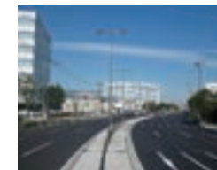
新木場二丁目道路復旧
